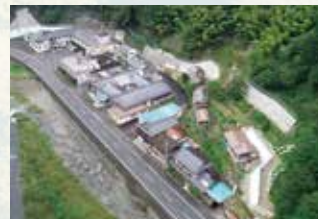
平成29年度 工砂第急29-24号 公共 防災・安全交付金 (急傾斜地崩壊対策事業)工事
