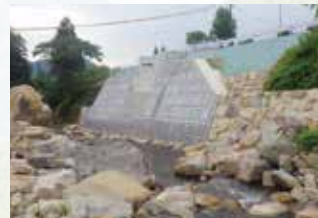
平成29年度 可中工第2902号 県営中山間地域 総合整備事業 東白川地区大明神集落道第2号工事
