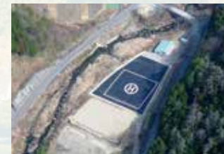
平成27年度 総工第23号 越原上ヘリポート建設工事
