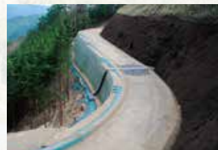
平成24年度 可林第2号 公共林道事業 尾城山線2工区工事
