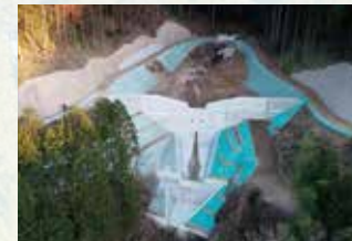
平成29年度 可治工第2909号公共 復旧治山事業 手掛岩2工事
